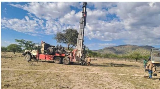
Die ersten Wassereinschläge kamen bei einer Tiefe von 8 Meter, 13 Meter und 27 Meter.
