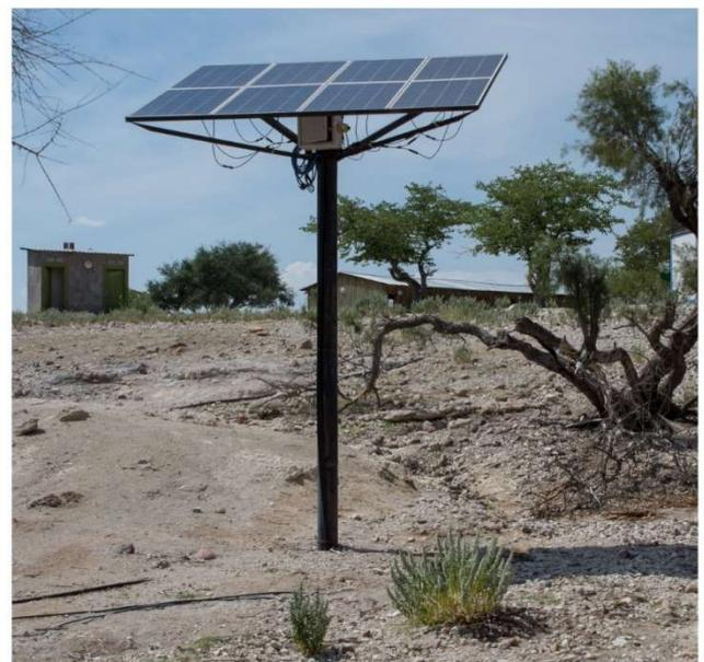
**Abb. Punkt 6:** Leider kann das Solarpanel aus dem allerersten Bohrloch nicht weiter verwendet werden, da die Leistung für die Pumpe am neuen Bohrloch zu schwach ist. Die Funktion für eine andere Verwendung muss noch geprüft werden.
