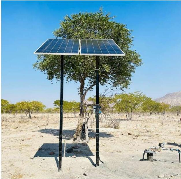
Hier wurde eine leistungsstarke Tiefbrunnen-Pumpe eingebaut, die bis zu 10.000 Liter in der Stunde fördern kann. Zuvor hatten die älteren Kids der Schule den 150 Meter langen Graben für die Wasserleitung ausgehoben. Das Werkzeug hierzu hatten sie sich von der Epupa Campsite ausgeliehen. Die Wasserleitung selbst wurde von der Firma Conserv Engineering gespendet.
