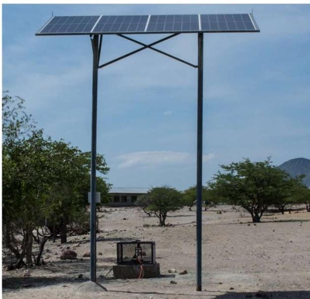
**Abb. Punkt 5:** Das zweite Bohrloch mit Pumpe und Solar am Trockenflussbett bleibt bestehen, falls es in den nächsten Jahren regnet und sich dort wieder Grundwasser ansammelt. Die Technik muss jedoch weiterhin gewartet werden.
