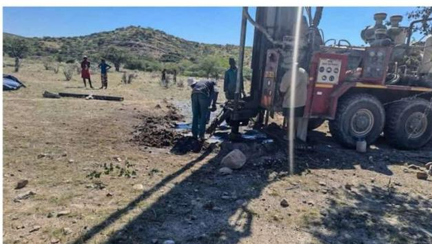
Insgesamt beträgt die Tiefe des Bohrloches 70 Meter. Der Wasserfluss liegt bei 7000 Liter in der Stunde mit einer hervorragenden Wasserqualität.
